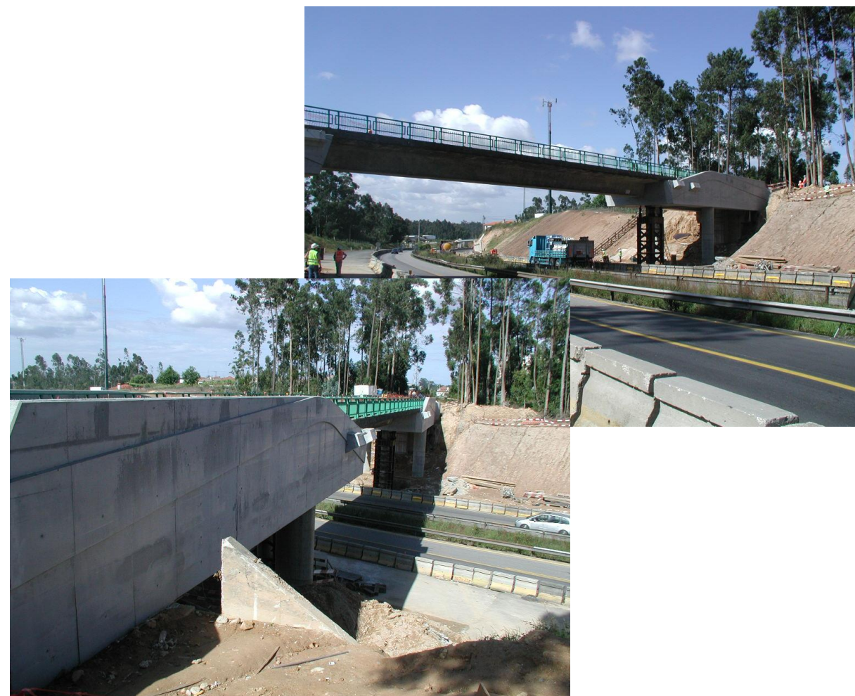
António Perry da Câmara y Carlos Cintra Vieira (2006). Aumento de vão de uma passagem superior ferroviária
