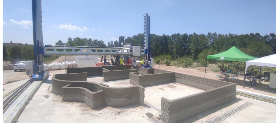
Impresora UBB en montaje en Valencia, España y Vivienda de Prueba
