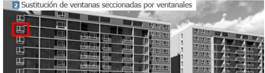
2 Sustitución de ventanas seccionadas por ventanales
