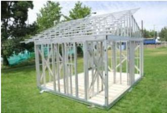
Imagen1, Sistemas en base a perfiles metálicos industrializados, montados en obra.
