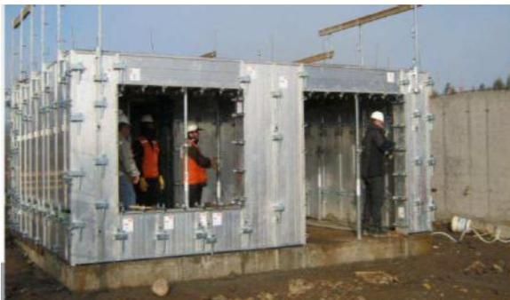
El proceso industrializado en unidades de viviendas en baja y en altura, consiste en un sistema de moldajes de aluminio estandarizado para hormigón monolítico, portable por un operador y dimensionados a la medida del proyecto, incluyendo detalles para solución de puertas y ventanas de tal forma de optimizar el sistema y mejorar la productividad del mismo, un hormigón que permite mayor fluidez en su llenado y enfierradura electrosoldada.
