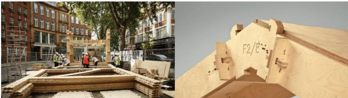
Imagen 1 y 2: Montaje de sistemas y conexiones. Fuente: <http://www.diariodelaconstruccion.cl/wikihouse-el-hagalo-usted-mismo-llega-a-la-construccion-de-casas/>
