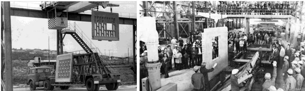
Imagen 1 y 2, fabricación de paneles. Fotografías, Nolberto Salinas Fuente: en: <http://www.plataformaarquitectura.cl/cl/623067/en-detalle-especial-sistema-de-panel-prefabricado-kpd/53acc18c07a8021be000030>
