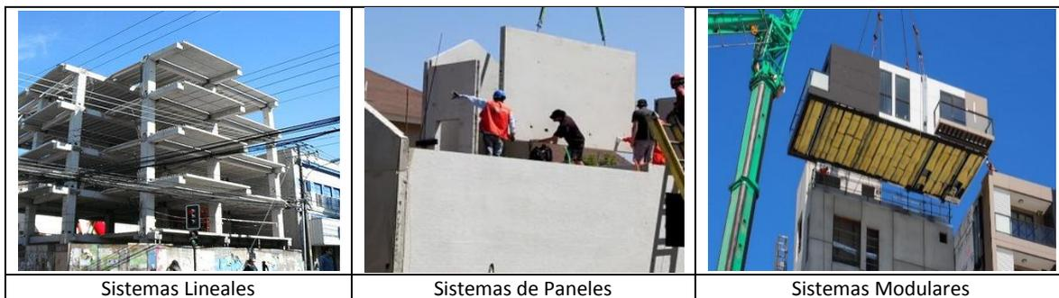
Figura 7.3. Ejemplos de distintos sistemas prefabricados. (fuente: [momenta.cl/baumax.cl/prefabaus.org.au](http://momenta.cl/baumax.cl/prefabaus.org.au))
