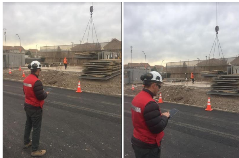
Observador registrando actividad, Obra Alto La Cruz, Baumax
