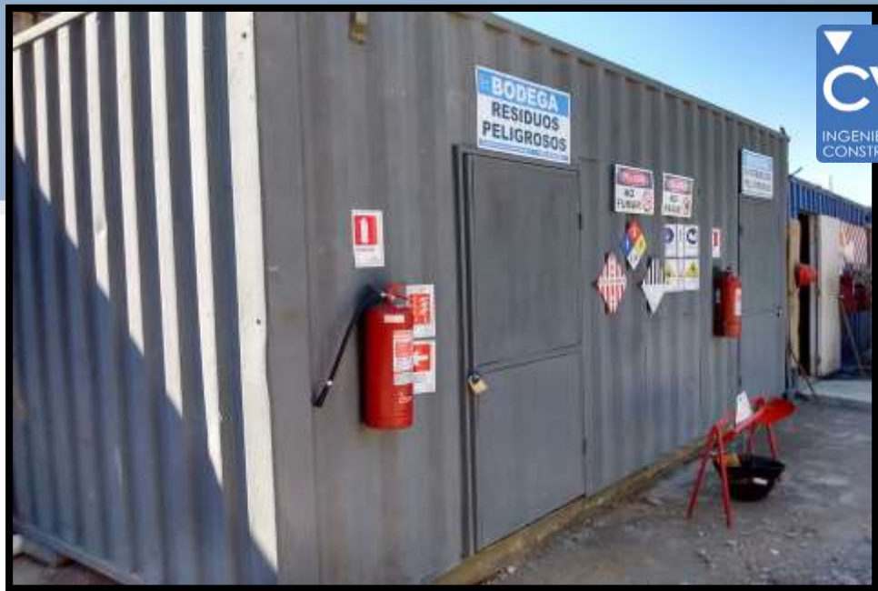
Container refaccionado para utilización de bodega de residuos peligrosos ( REUTILIZABLE).
