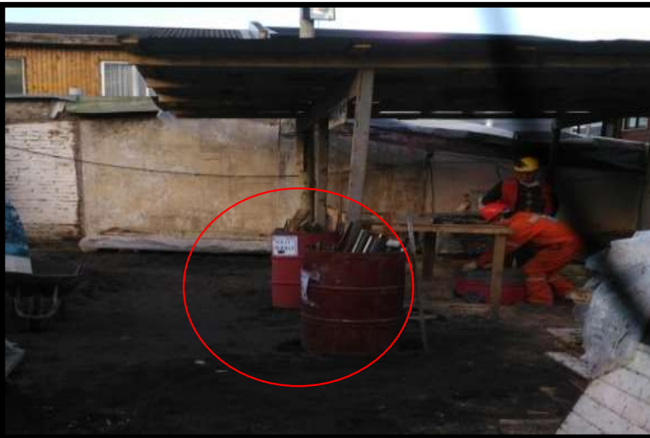
Taller de trabajo despejado y limpio
