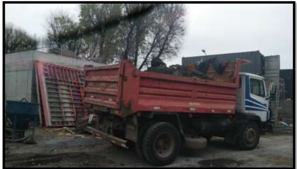
Retiro de restos de Hormigón y Tierra
