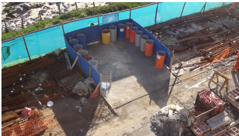
Ilustración 2: Zona 1: Punto Limpio 1 (Ubicado entre los edificios)
