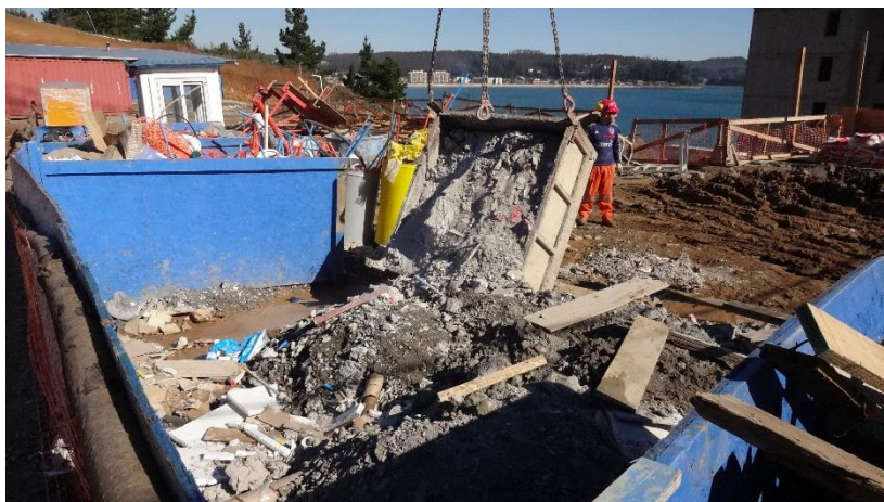
Ilustración 5: Zona 2: Punto Limpio Principal (Acopio de escombros)
