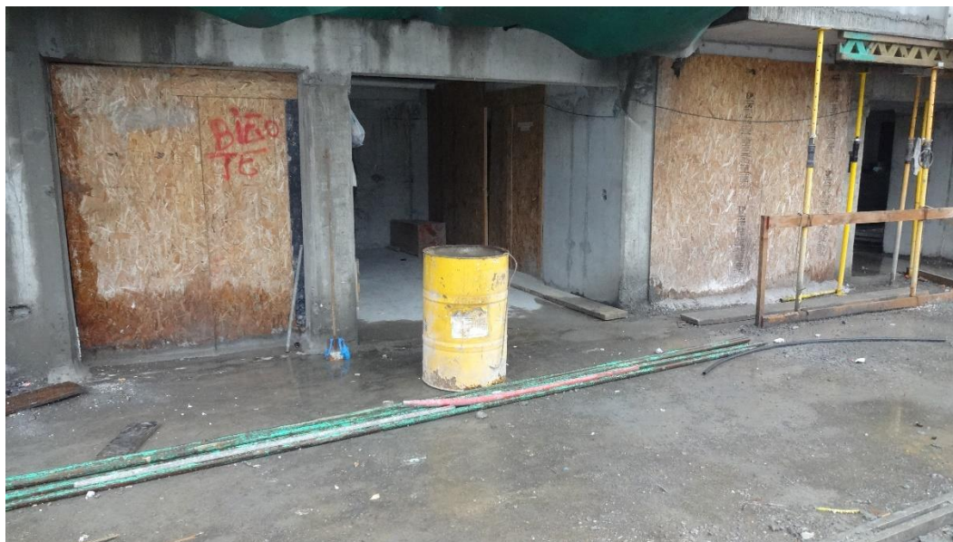
Nota: Bodegas de los subcontratos, ubicadas en el piso 1.
