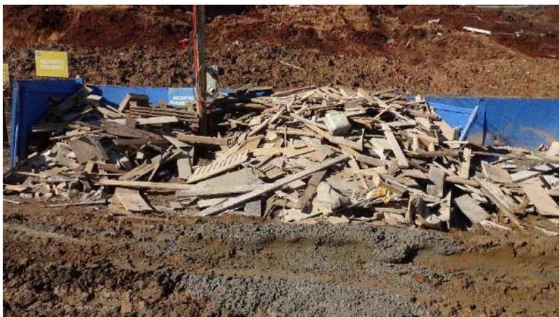
Ilustración 4: Zona 2: Punto Limpio Principal (Acopio Madera) (CITEC-UBB)
