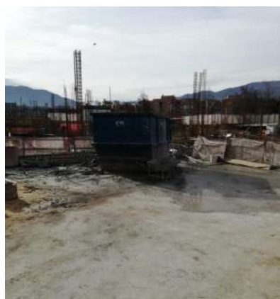
Contenedor de escombros
