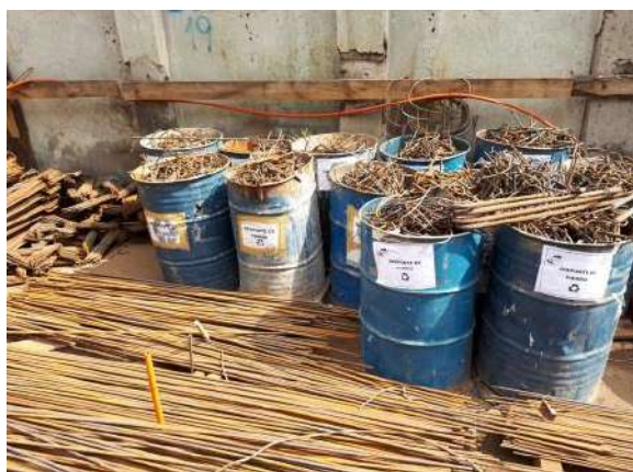
Acopio de despuntes de fierro
