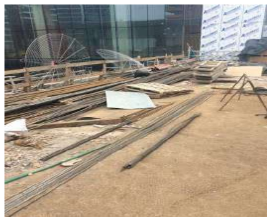
Acopio de fierro
