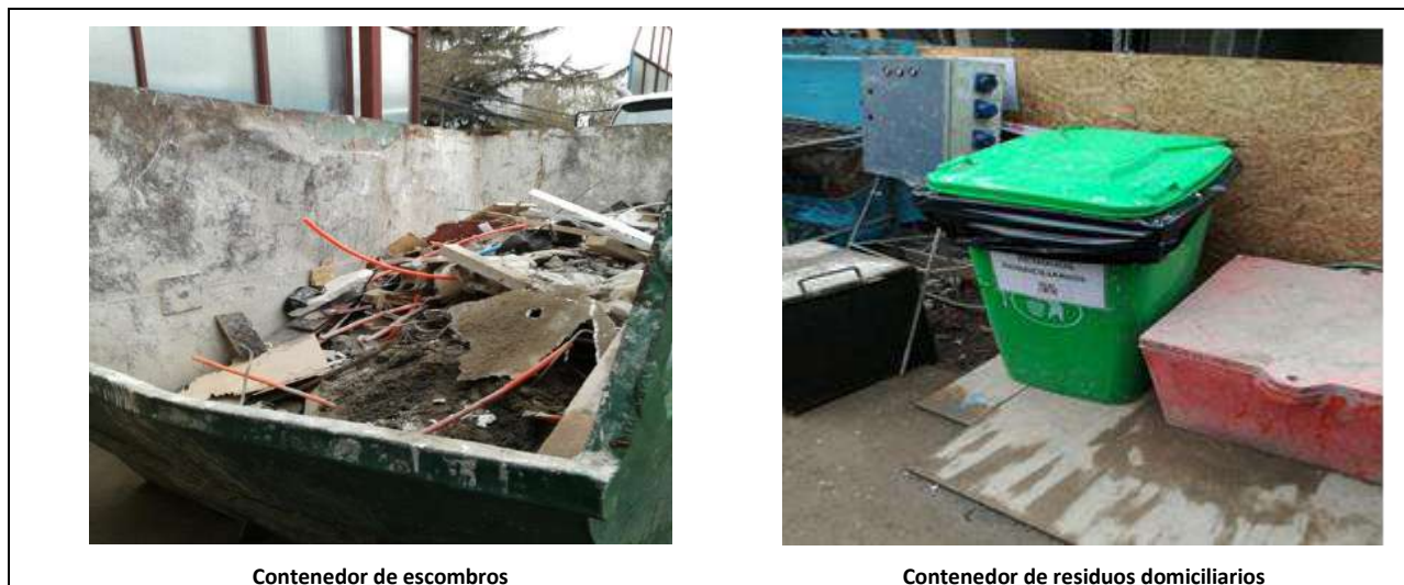
Contenedor de escombros
