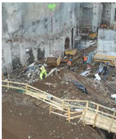
Contenedor de escombros
