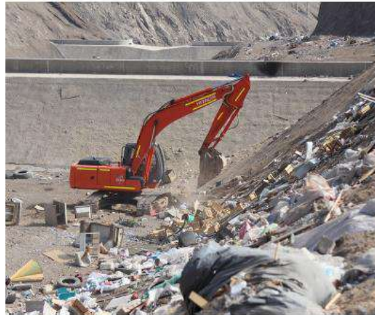
$100 millones para realizar trabajos de limpieza y retiro de escombros de las vías aluvionales de Antofagasta. (MOP)
