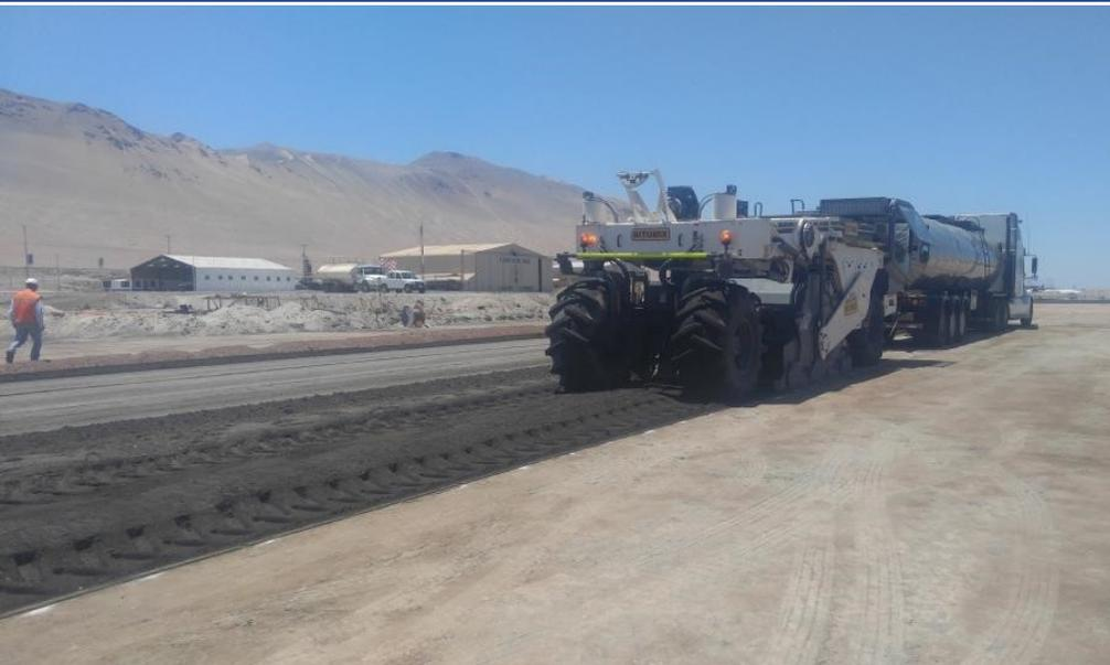
Proceso de Reciclaje y estabilización in-situ de la base existente, Iquique 2016
